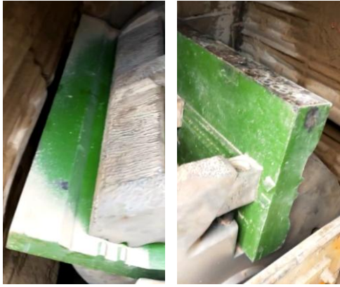
MMC -Cr2021 板锤安装 MMC -Cr2021 blow bar install
